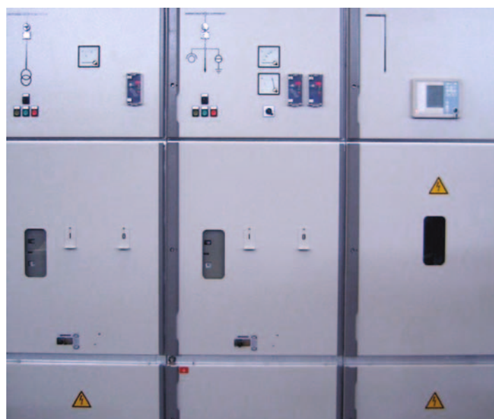
10 kV SPREPOWER Mittelspannungsschaltanlage
