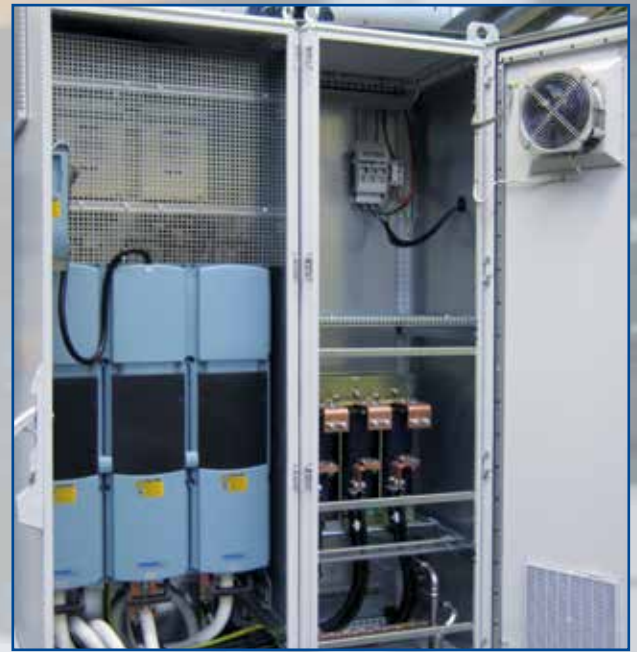
Frequenzumformeranlage
