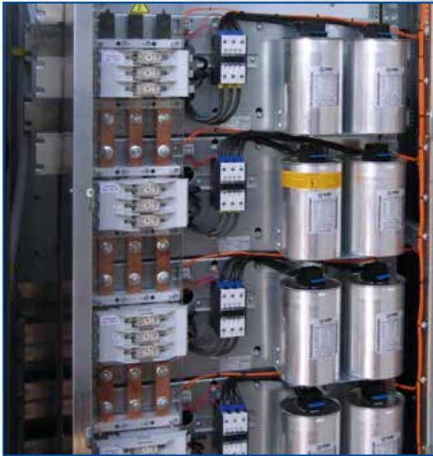
Blindstromkompensationsanlage
